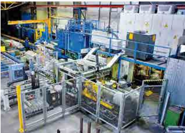
MBH einlaufseitig zu einer Strangpresse MBH at the entry side of an extrusion press
