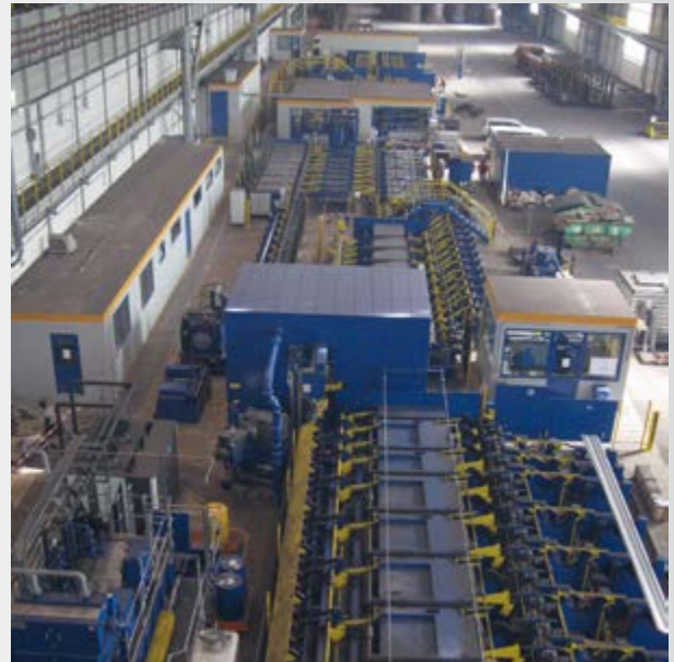
Schlüsselfertige Blankstahllinie für hochfeste Stahlstangen
