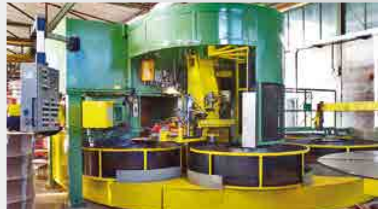
Spinnerblock, ebenerdiger Aufbau für Kupferrohre Spinner block for copper tubes, installed at ground level
