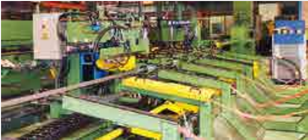
Späneausblasanlage inkl. Spänepresse und mit Fasanlage für Stahlrohre, im Auslauf einer Rohrschweißanlage Swarf blow-off unit, incl. swarf press and chamfering machine for steel tubes, installed in the runout of a tube welding line
